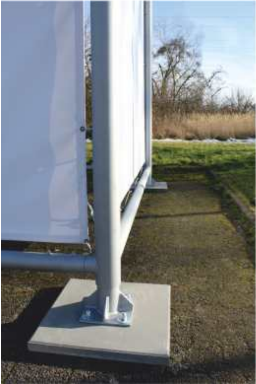
Stahlstandpfosten mit Knotenblechen und Sockelplatte, verzinkt.
