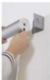
Winkel an die Wand schrauben
